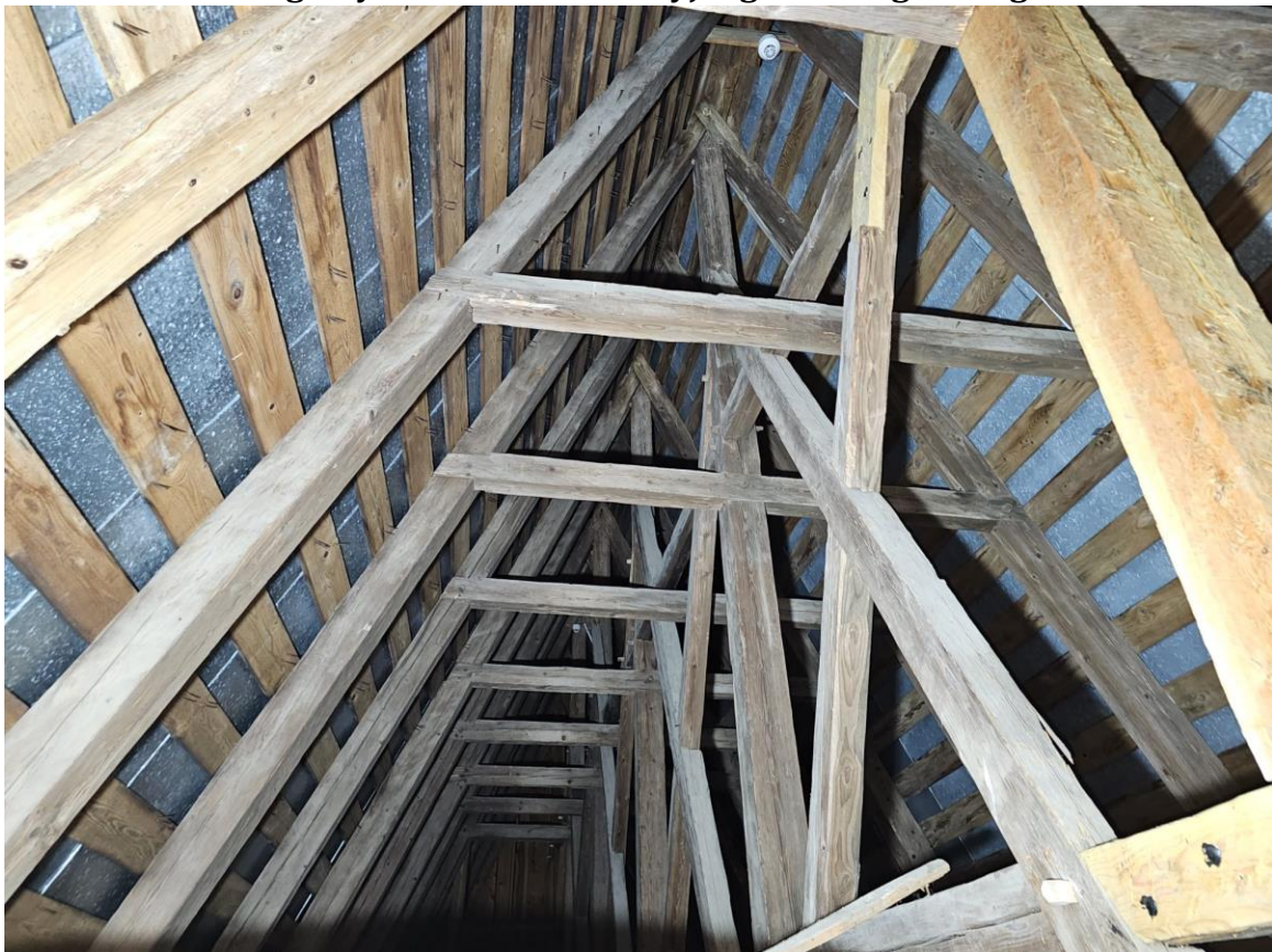
Widok ogólny więźby dachowej; widoczna rama storczykowa
