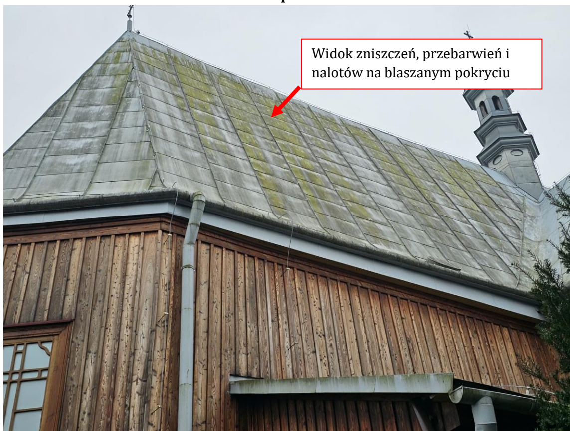
Szczegółowy widok stanu zachowania blaszanego pokrycia dachu prezbiterium – strona północna
