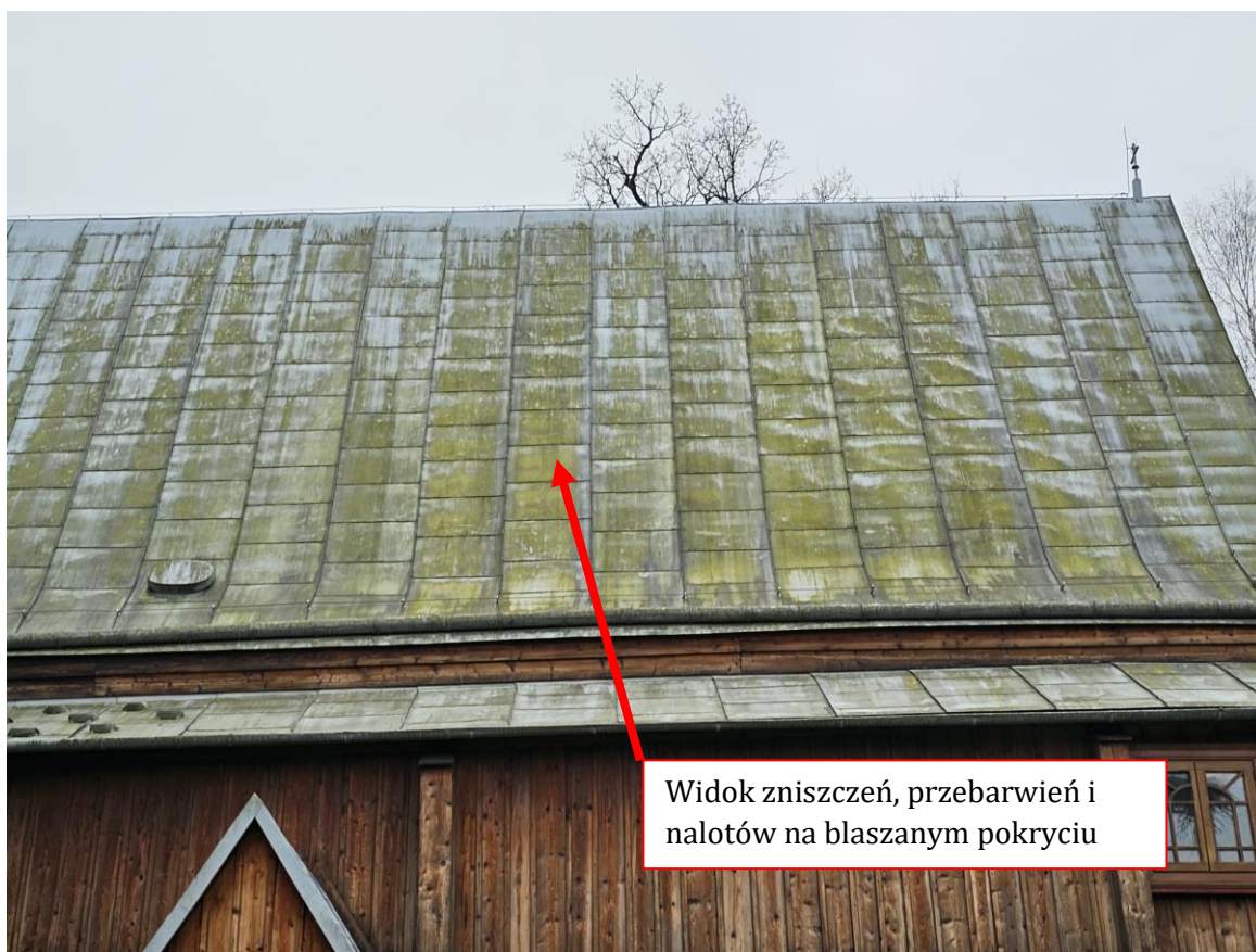
Szczegółowy widok stanu zachowania blaszanego pokrycia dachu nawy – strona północna
