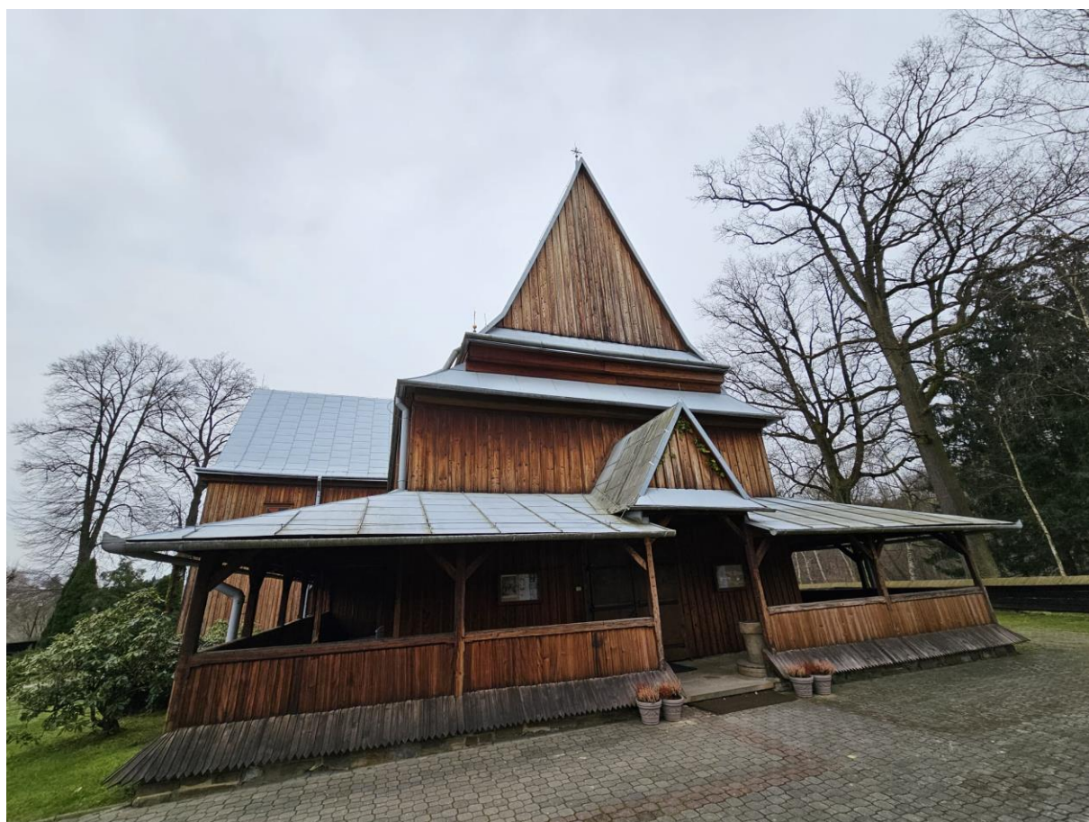
Widok ogólny pokrycia połaci dachowych kościoła- strona zachodnia
