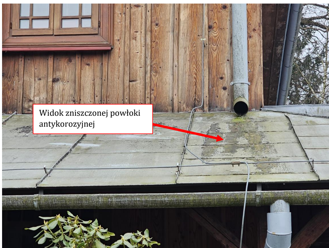
Szczegółowy widok stanu zachowania blaszanego pokrycia dachu sobót – strona północna
