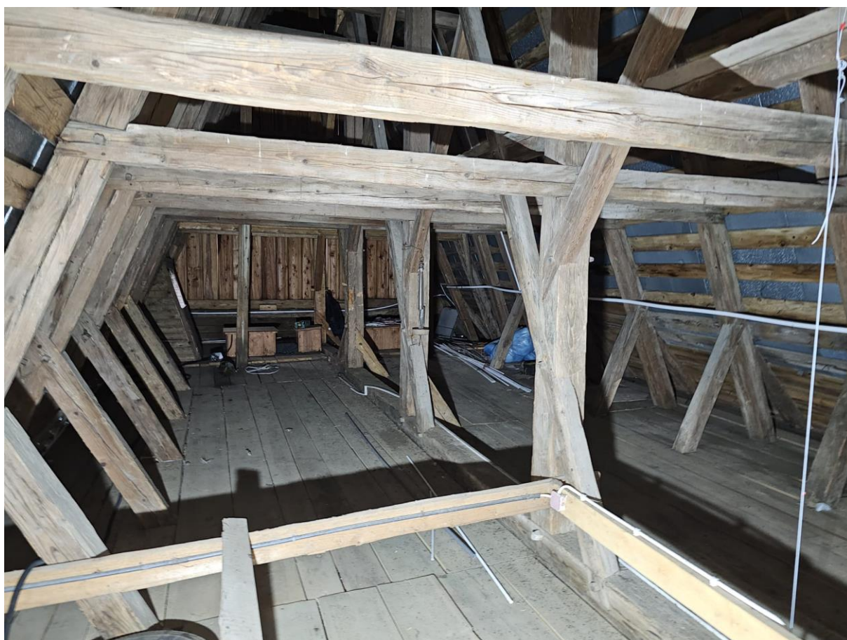
Widok ogólny więźby dachowej; widoczna rama storczykowa
