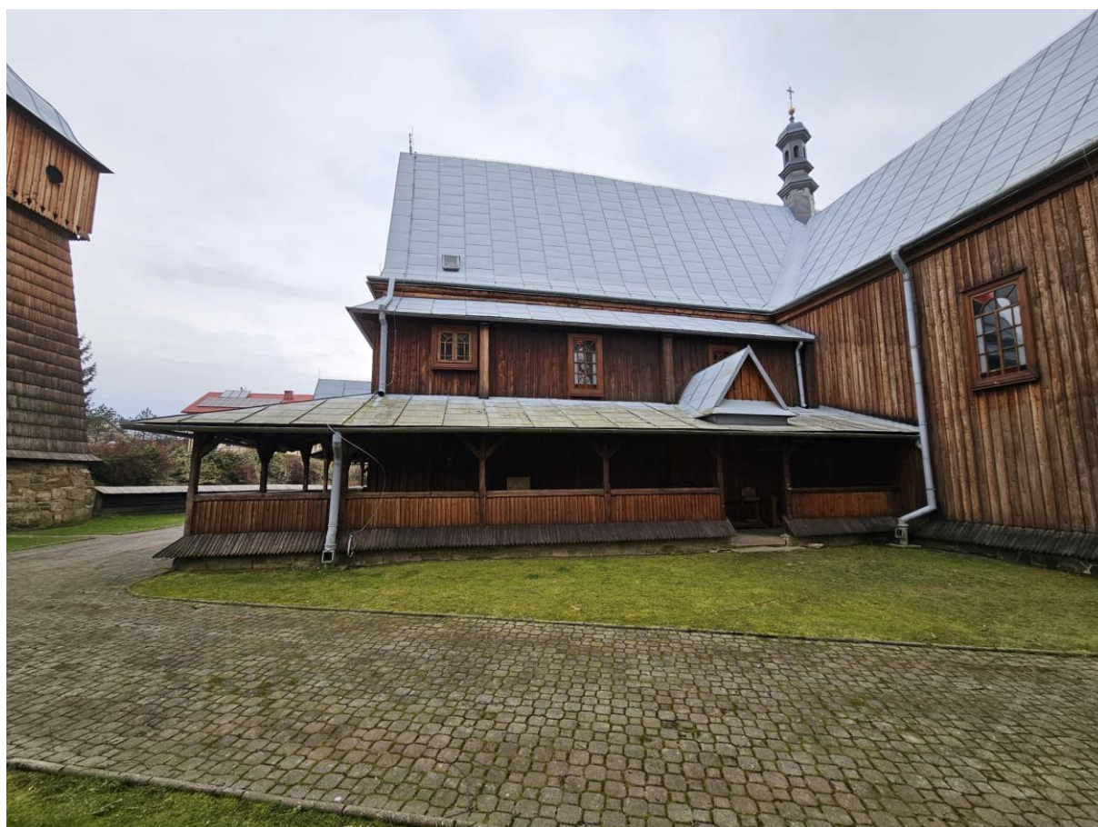
Widok ogólny pokrycia połaci dachowych kościoła- strona południowa
