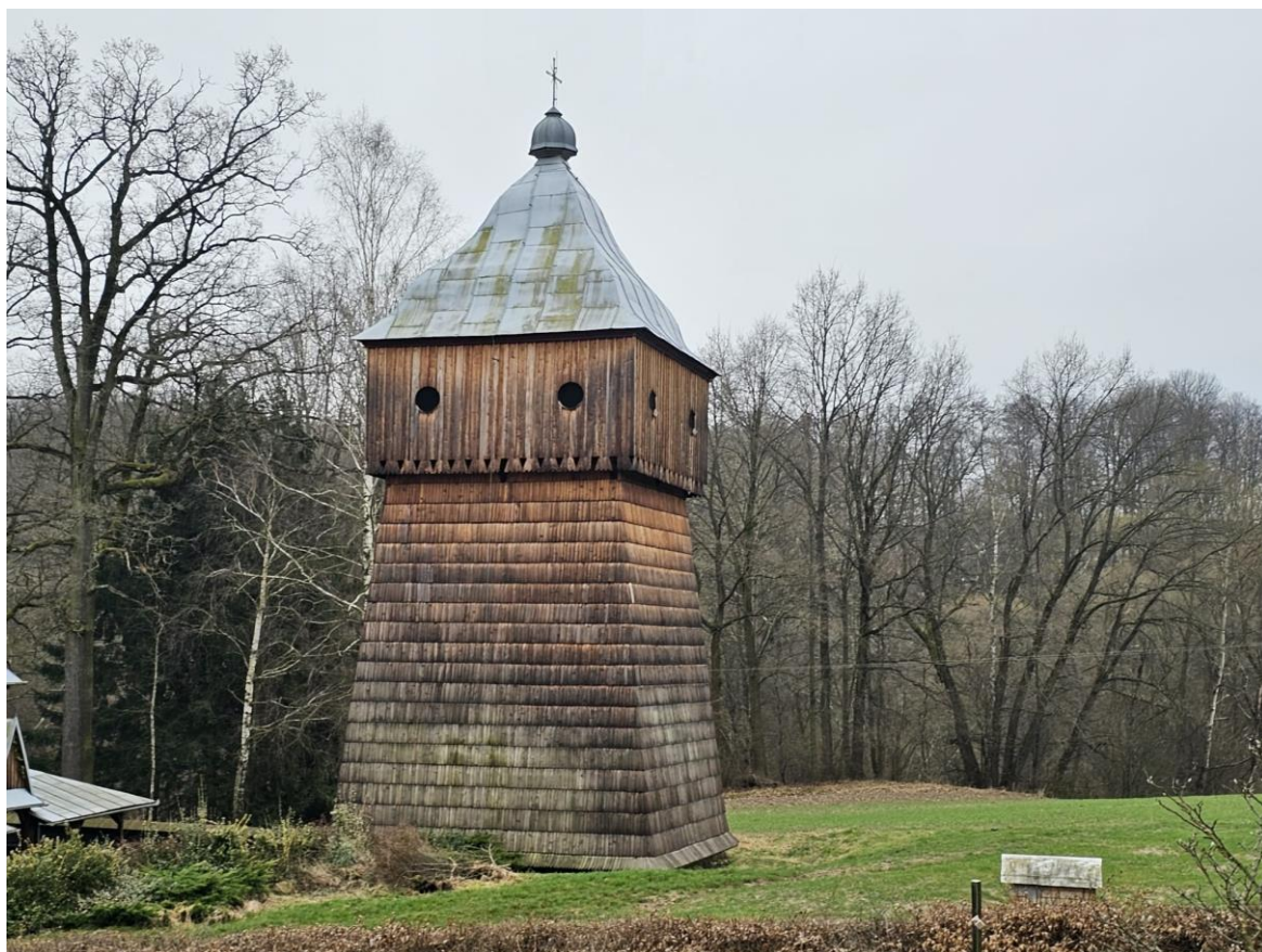
Widok ogólny stanu zachowania blaszanego pokrycia dachu dzwonnicy - strona północna
