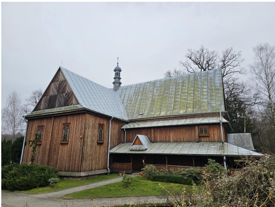
Widok ogólny pokrycia połaci dachowych kościoła- strona północna
