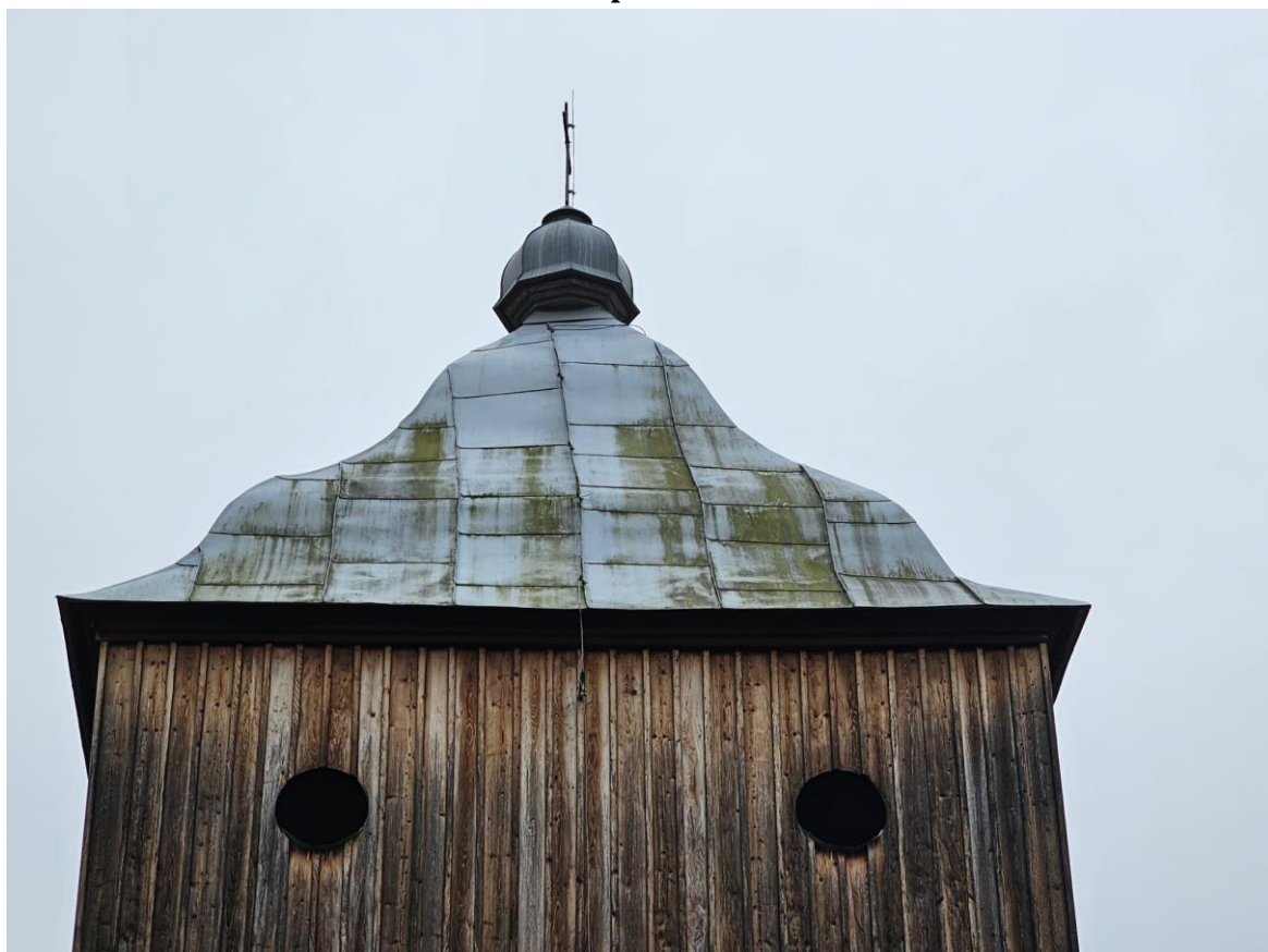
Szczegółowy widok stanu zachowania blaszanego pokrycia dachu dzwonnicy - strona północna
