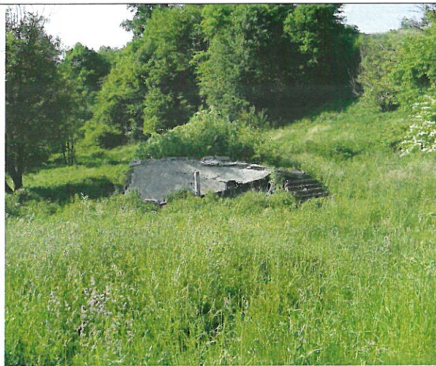
Koluwia z widocznym zniszczonym domem
