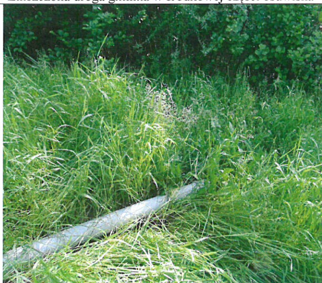
Wylot kanalizacji na osuwisku
